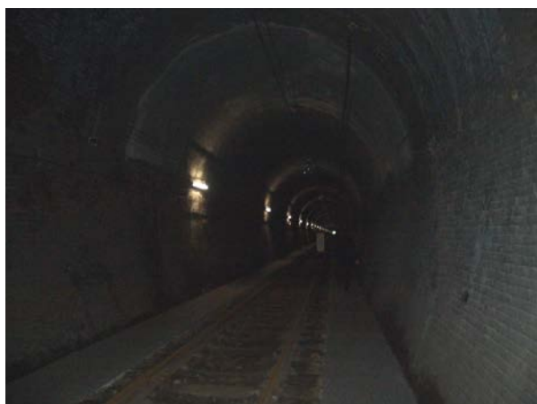
大日影トンネル遊歩道内部の状況
