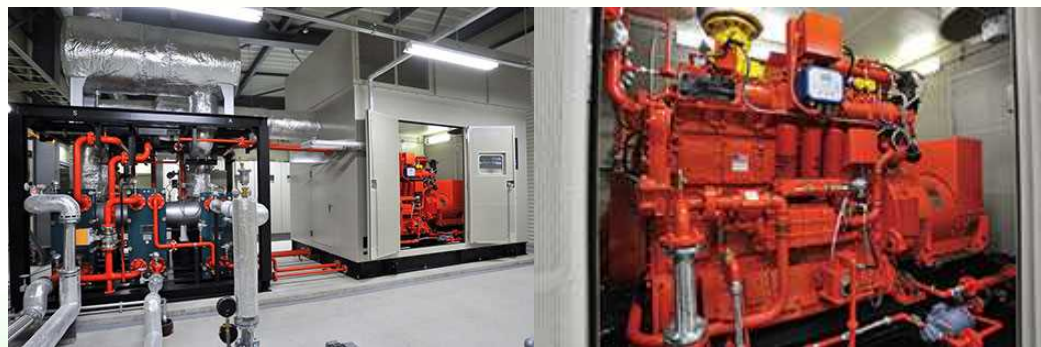
エネルギー棟内(左)とガスエンジン(右) (出典 JファームHP)
