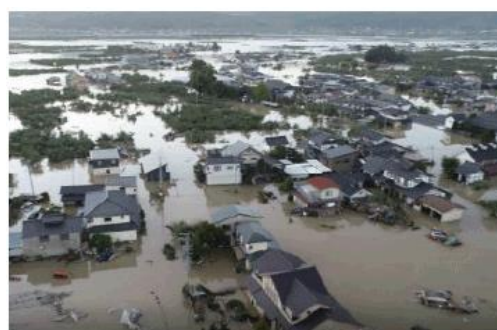
b) 「令和元年東日本台風」による被災状況
