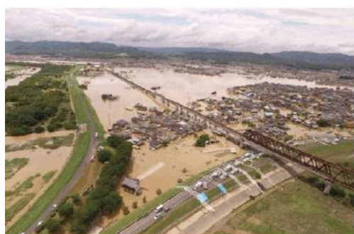
a) 「平成 30 年 7 月豪雨」による被災状況
