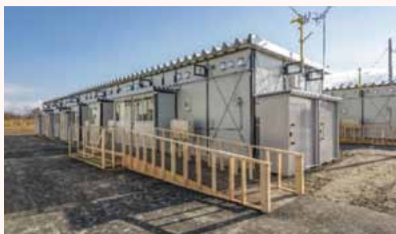
応急仮設住宅（プレハブ レンタル）
