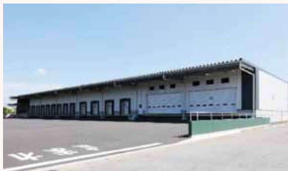
低温荷捌き場（重量S造）
