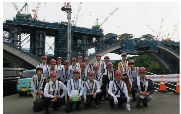
施工箇所での集合写真
