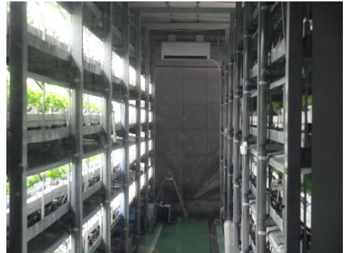
地下植物工場内部 片側24個のセルが並ぶ
