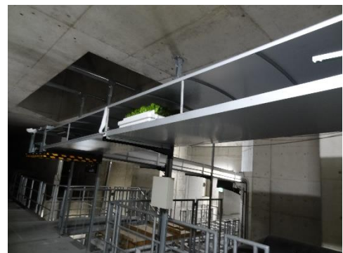
作物（レタス）のパレットを 地上に運搬するコンベヤ
