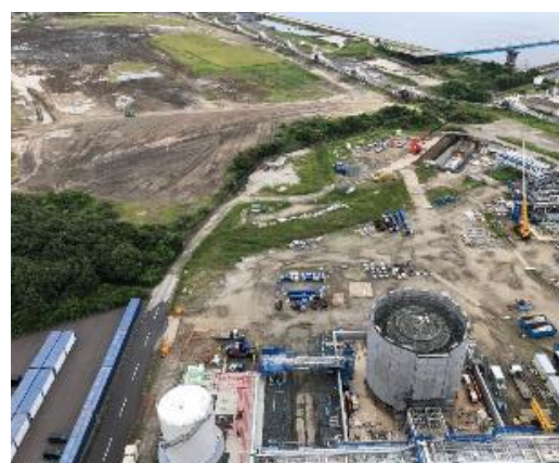
燃料アンモニア設備工事中
