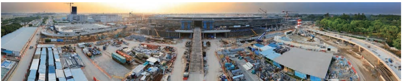
工事中写真（正面にメインターミナルビル、左に管制塔を望む）
